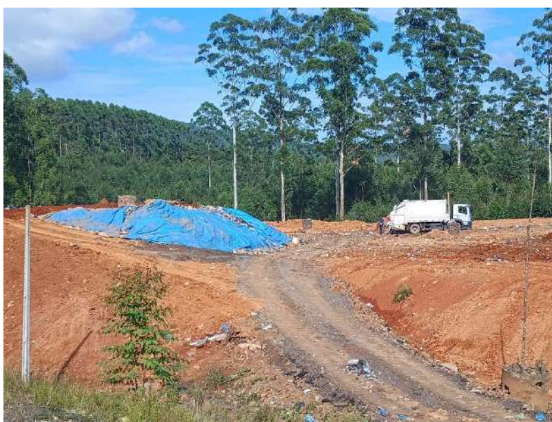
Figura 6: Cobertura dos resíduos com manta de sacrifício, fevereiro de 2024.
