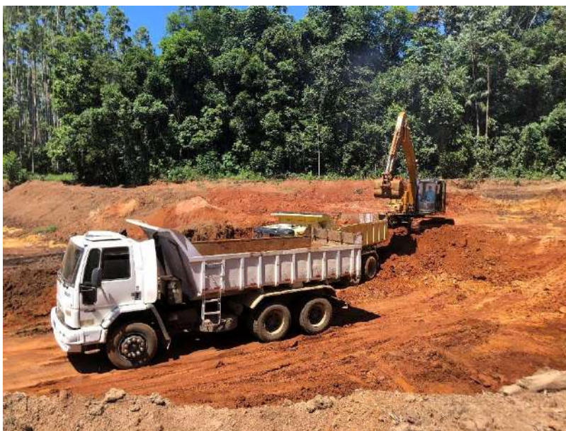
Figura 21: Operação da jazida de argila, março de 2024.
