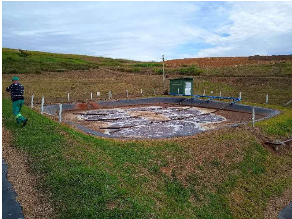
Figura 12 – Lagoa aerada com novo sistema de aeração Lodos Ativados – maio 2024.
