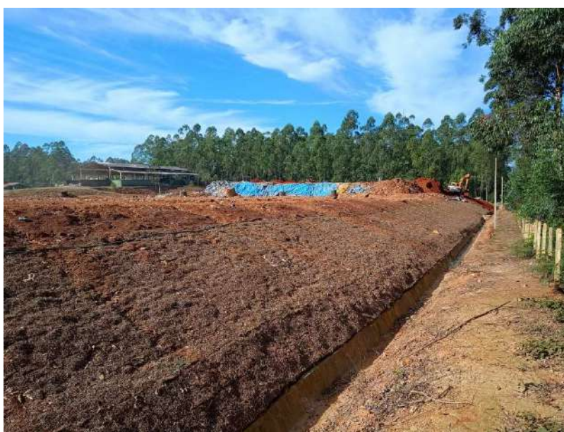
Figura 4: Manutenção da frente de serviço, abril de 2024.
