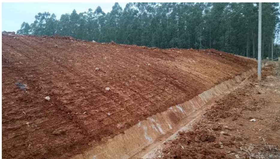
Figura 9: Drenagem pluvial em concreto, setembro 2023.
