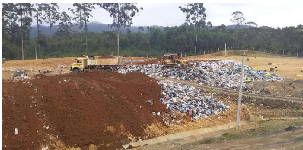
Figura 3: Vista da operação da frente de serviço, junho de 2023.
