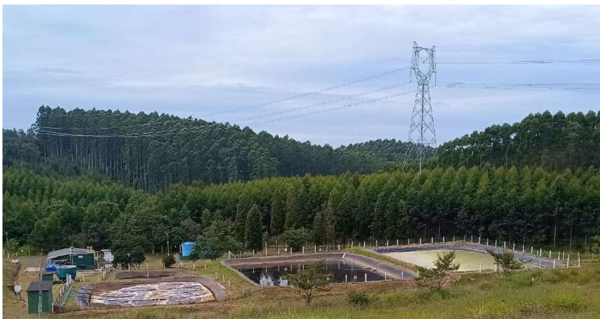
Figura 11 – Vista geral das instalações da ETE biológica – maio 2024.
