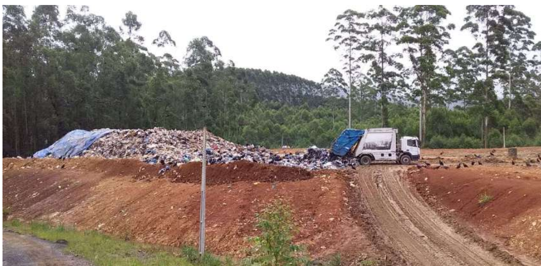
Figura 5: Descarga dos resíduos em períodos de chuva, janeiro de 2024.
