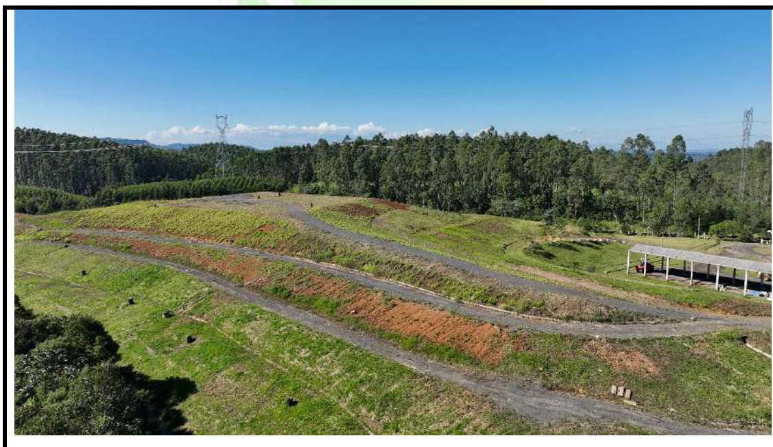
Figura 2: Vista aérea da conformação geométrica dos taludes.
