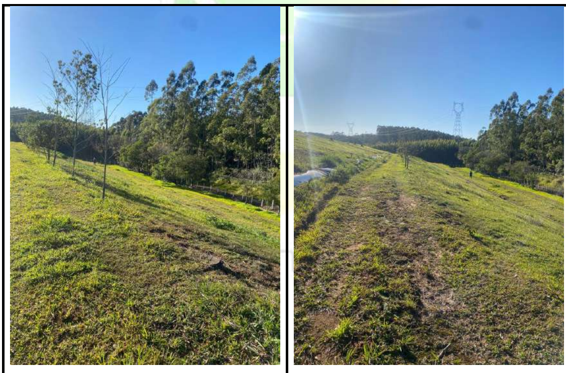
Figura 2: Vista da conformação geométrica dos taludes.
